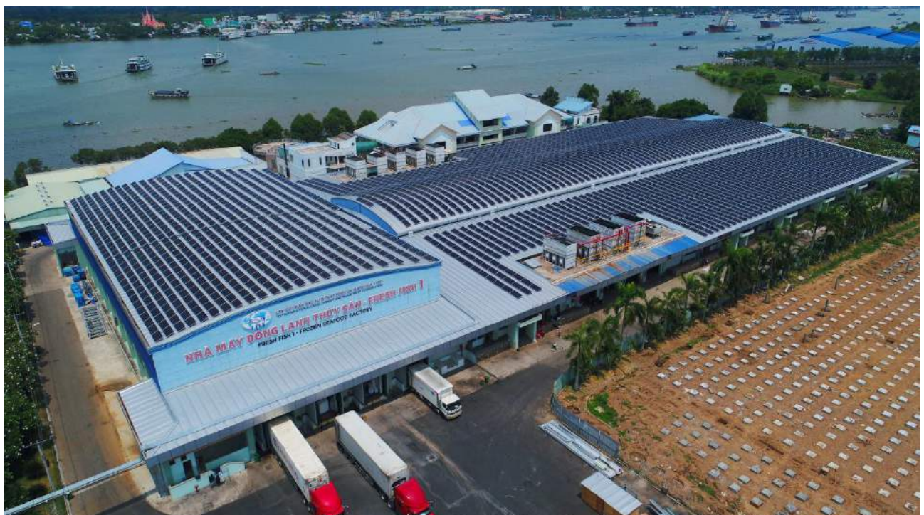
Hệ thống điện mặt trời của Nhà máy đông lạnh thủy sản số 1 do Tập đoàn Sao Mai lắp đặt
