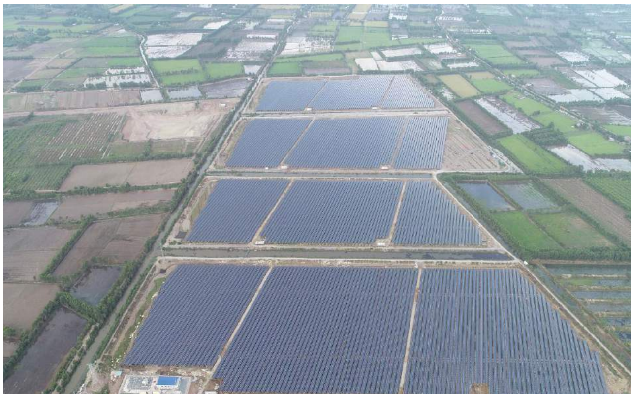
Nhà máy điện mặt trời Europlast Long An tại xã Mỹ Thạnh Bắc, huyện Đức Huệ, tỉnh Long An
